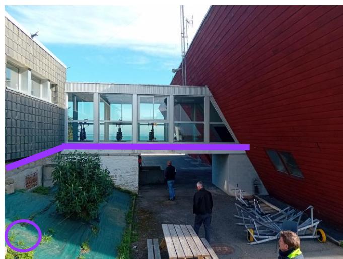
Passage refoulement en extérieur vers la cuve tampon enterrée (capotage protection UV)
